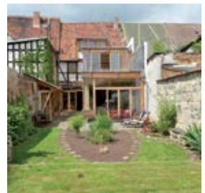
Gartenbereich eines sanierten Hauses
