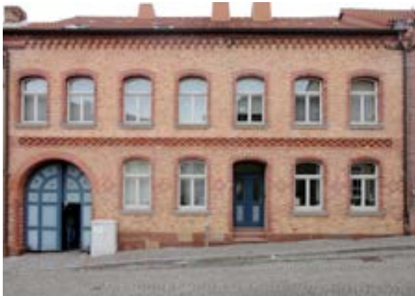
Originalfassaden des 19. Jahrhunderts prägen das Stadtbild
