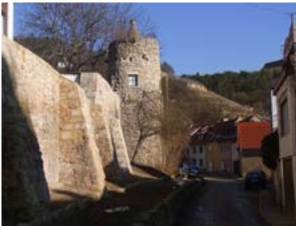
Instandsetzung und Neugestaltung im Bereich der Stadtmauer
