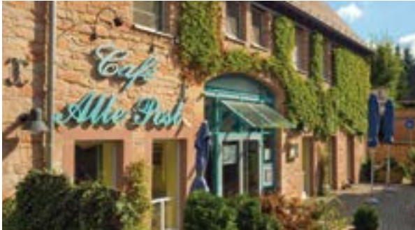
Beispiel für sanierte Scheunen mit neuer Nutzung (Café)
