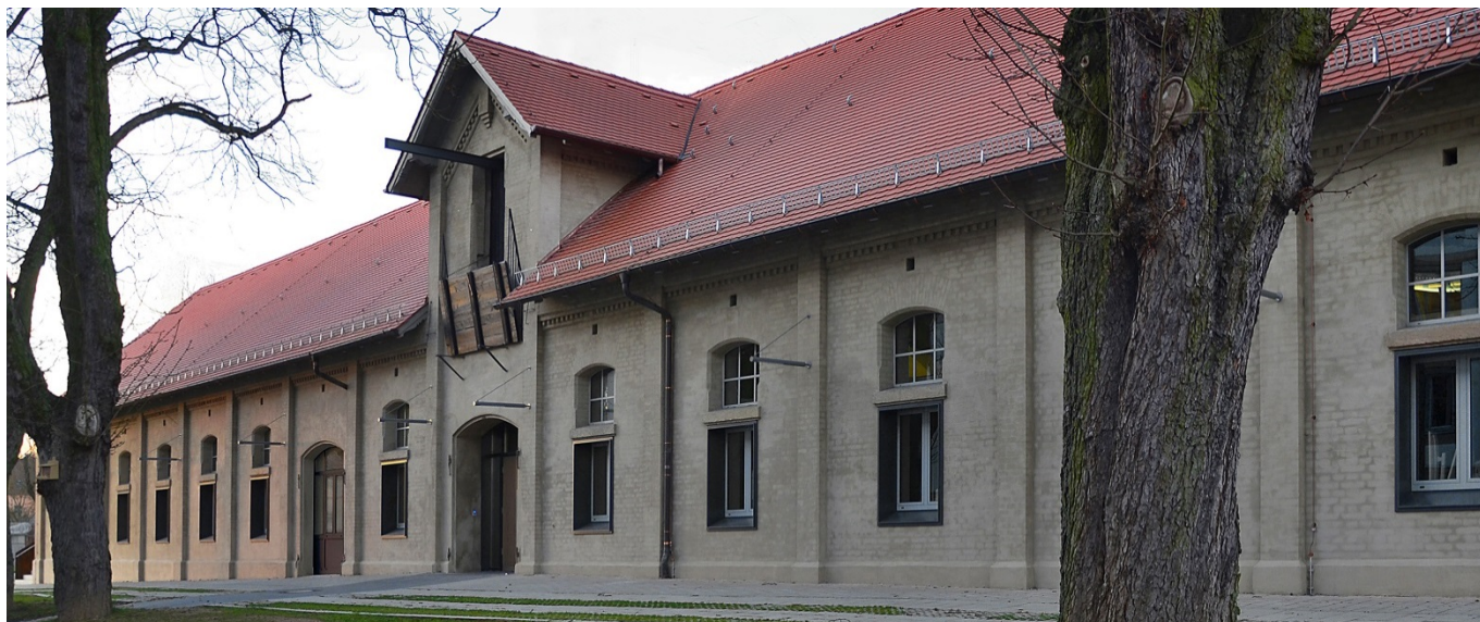
Südfassade (Foto StBA Ansbach)
