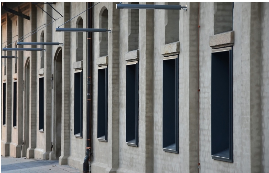
Detail Fassade (Foto StBA Ansbach)
