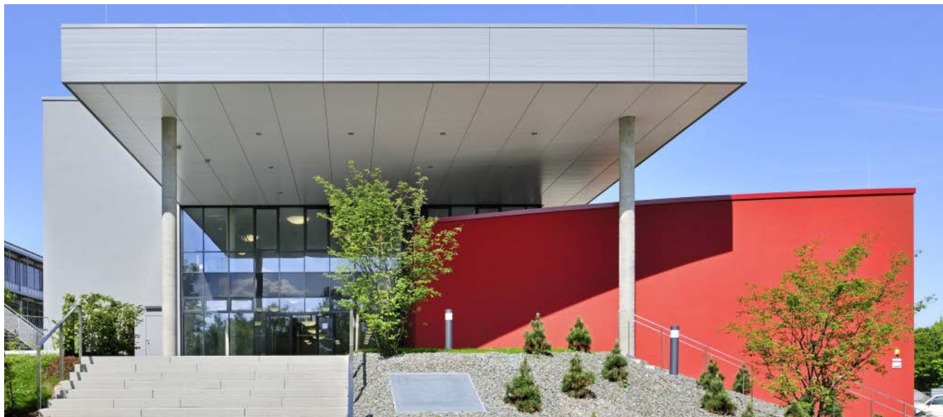
Eingangssituation Ost (Foto: R. D. Bischoff, Nürnberg)
