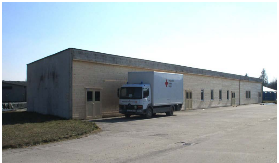
Ertüchtigung der ehemaligen Fahrzeugunterstände (Foto © StBA FS)
