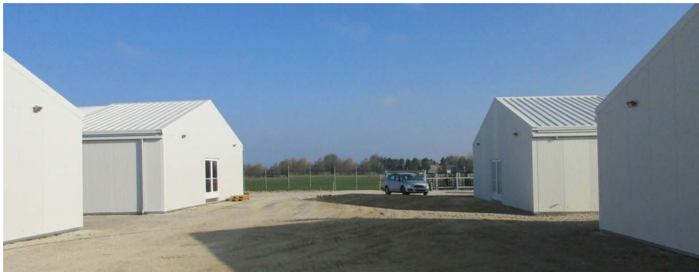
Leichtbauhallen als Unterkunftshallen im Fliegerhorst Erding (Foto © StBA FS)
