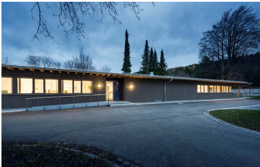
Ostansicht (Foto: H. Rupp, Kempten)
