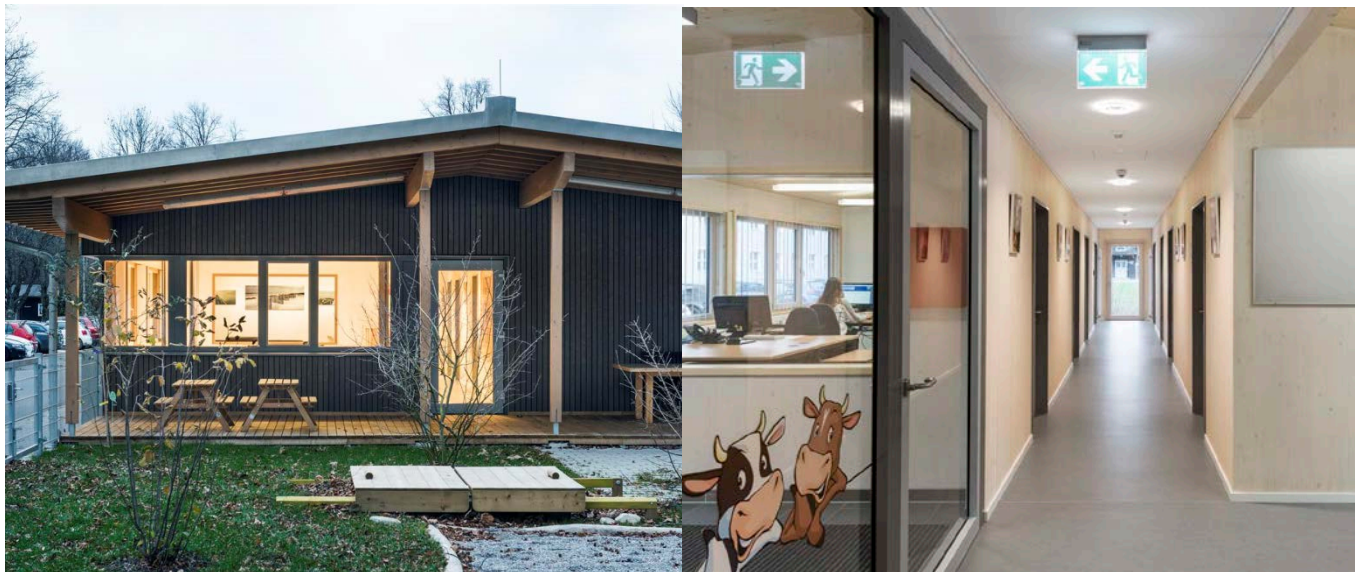
links: Südansicht mit Terrasse; rechts: Flur nach Süden (Fotos: H. Rupp, Kempten)
