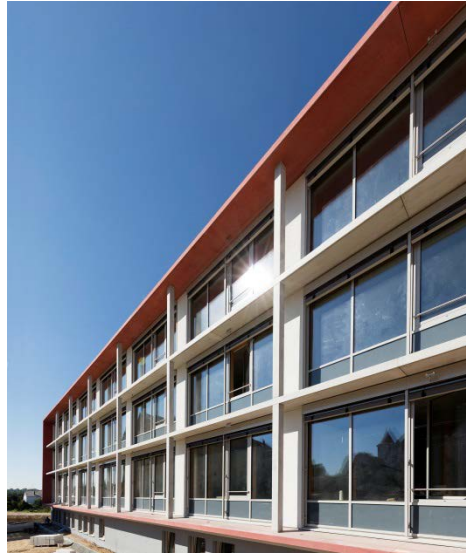
Ostansicht Putzbalkone (© Matthias Sienz)
