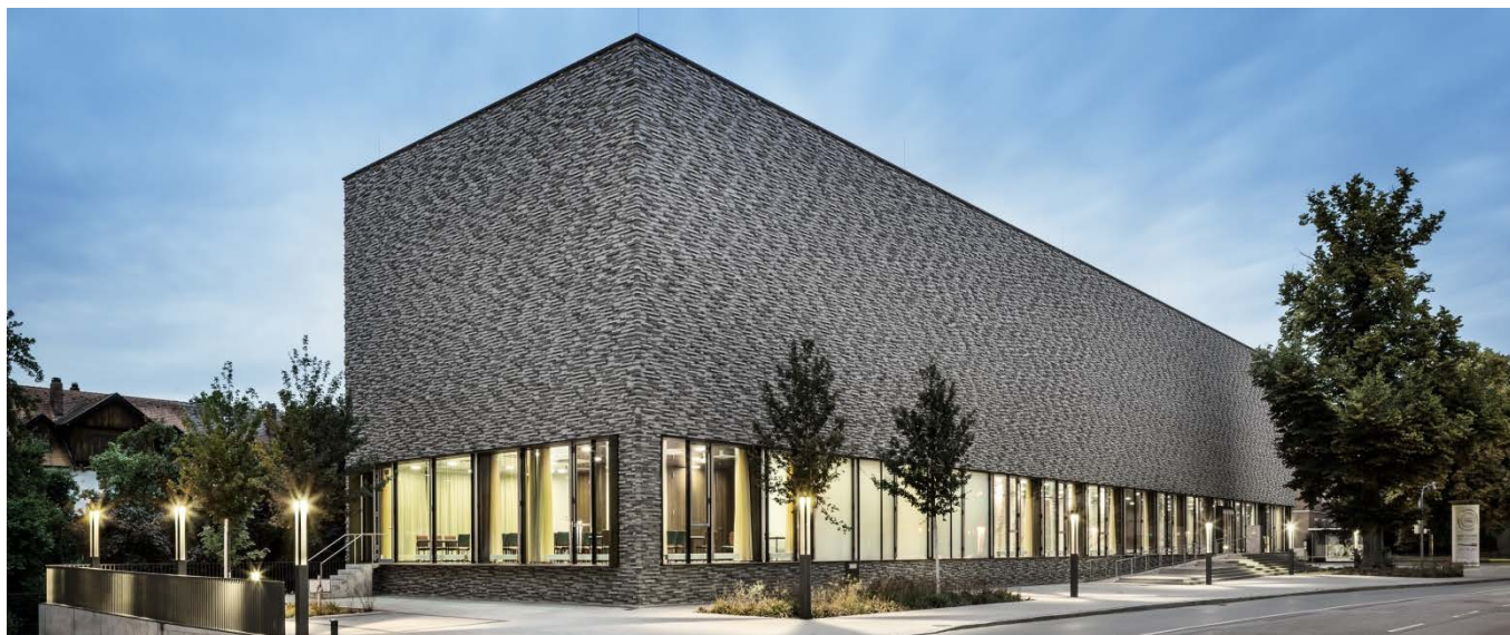
Ansicht zur Schlachthofstraße mit Haupteingang (Foto © 2016 Litvai)
