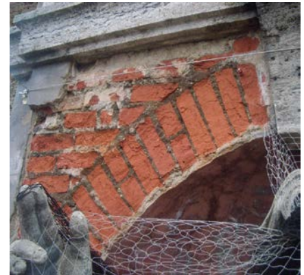
Abtrag Giebel (Foto: Bauamt)
