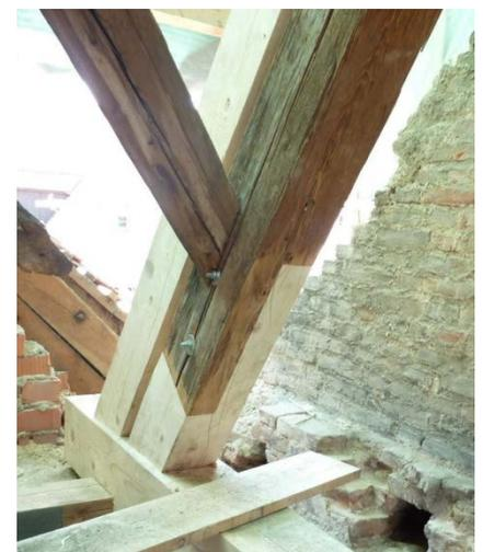
*Morsche Balkenfüße des Dachtragwerks – wie hier im Westturm – wurden querschnittsgleich ersetzt (Foto ©Staatliches Bauamt Passau)*
