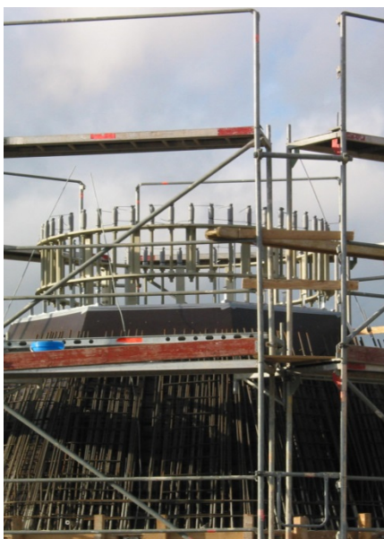
Armierungsanteil Ankerring (Foto: StBA R)
