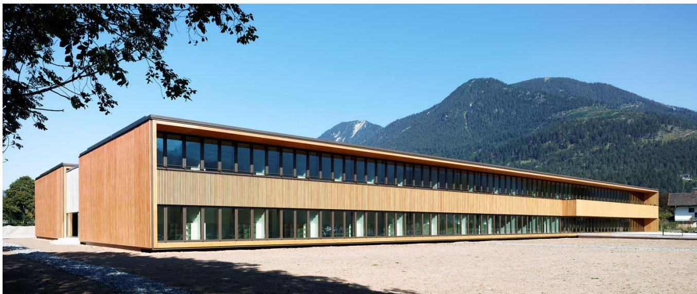
Südansicht Finanzamt Garmisch-Partenkirchen (Foto: Jens Weber, München)
