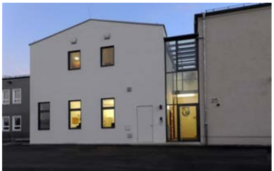
Fassade Nord, Zugang Feuerwache © C.Kurz
