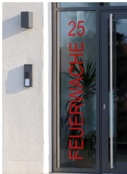
Fassade Nord Erweiterung (© C.Kurz)
