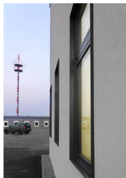
Fenster fassadenbündig (© C.Kurz)
