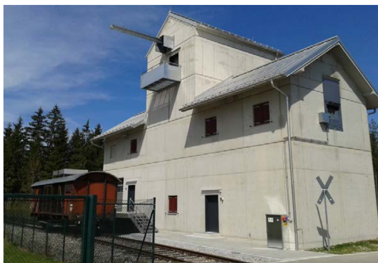
Südostansicht (Foto © StBA WM)
