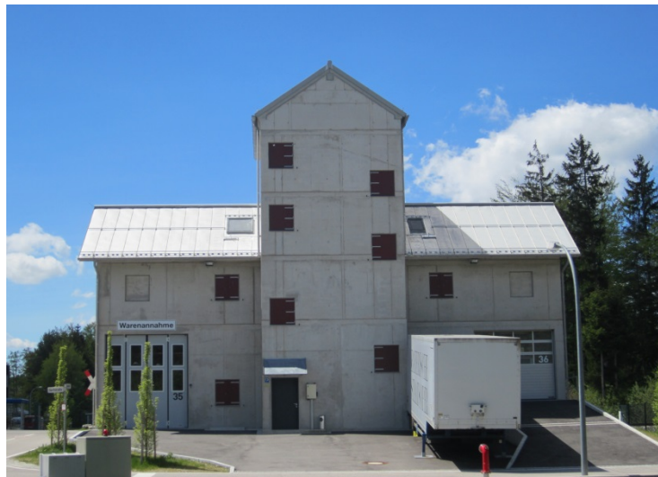
Nordansicht Übungsobjekt „Lagerhaus mit Rampe“ (Foto © StBA WM)
