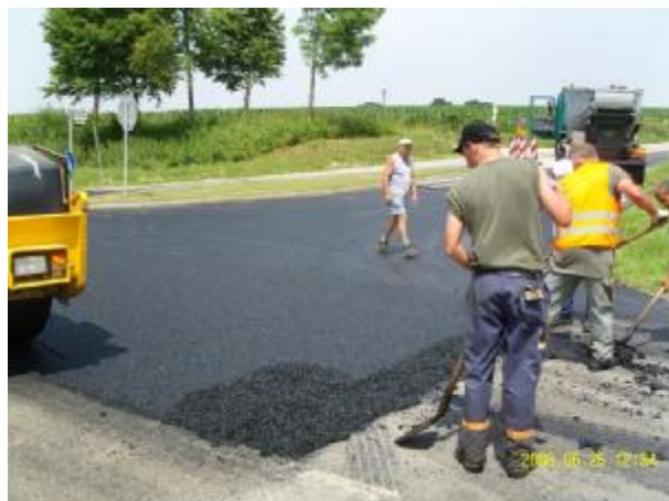
Bild 833: Bau-km 0+808 Restarbeiten von Hand am Ansatz zu Bauphase 2
