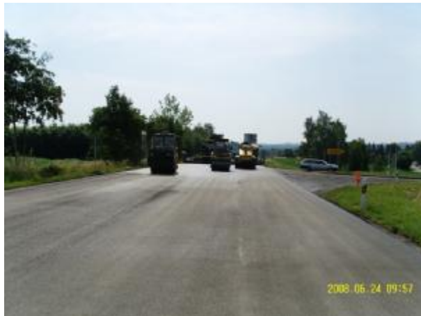
Bild 744: Bau-km 1+550 konturenartige Querunebenheiten und ungleichmäßiges Streubild
