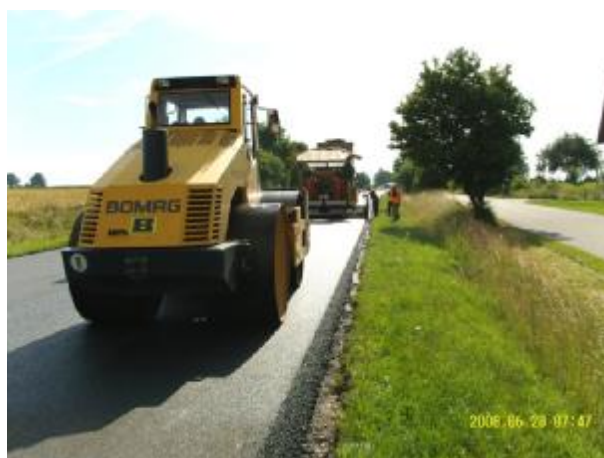
Bild 614: Bau-km 0+180 Dreiradwalze Bomag BW 213 AD 3
