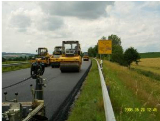
Bild 673: Bau-km 1+150 Walzenfolge bei Einbau und Verdichtung in voller Breite
