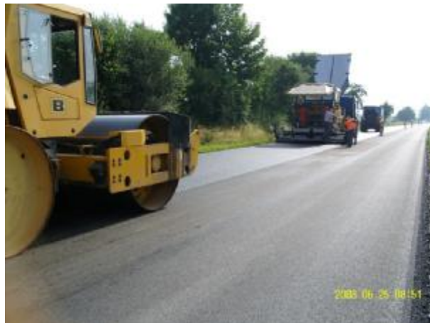
Bild 804: Bau-km 0+245 Verdichtung des Reststeiges neben der Nahtzone
