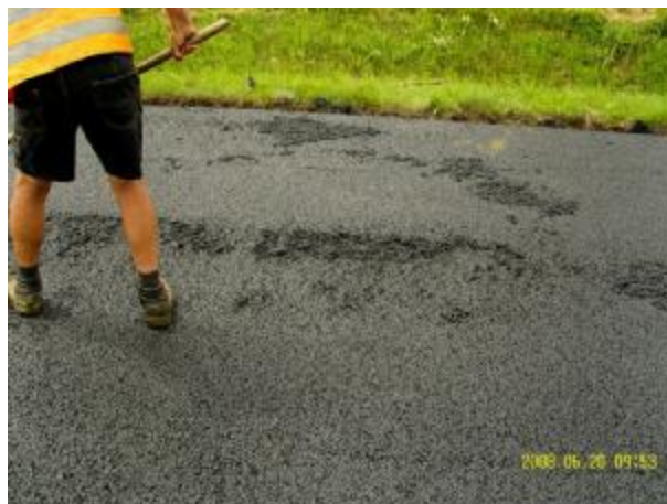
Bild 637: Bau-km 0+700 Nachlegen von Asphaltmischgut wegen unregelmäßiger Schicht
