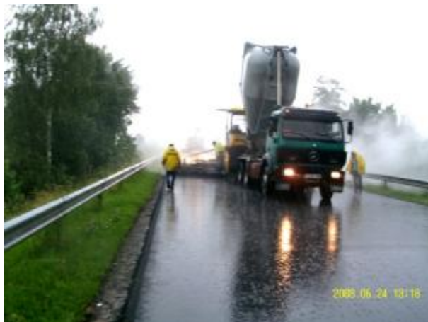
Bild 761: Bau-km 2+167 Einbau bei starkem Regen
