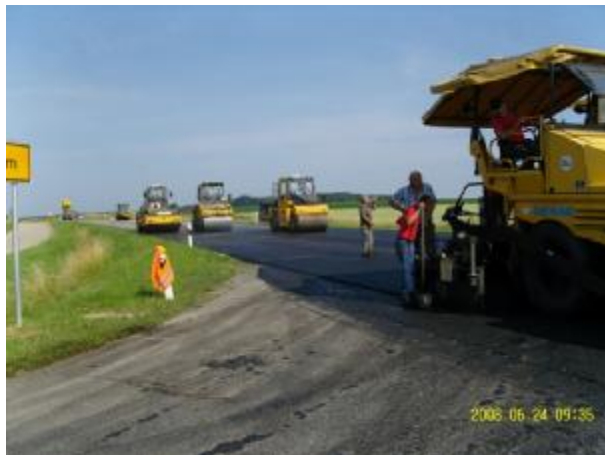
Bild 742: Bau-km 1+540 Walzenfolge bei voller Einbaubreite mit zwei Fertigmern
