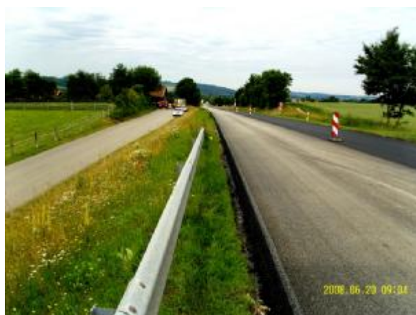
Bild 626: Bau-km 0+375 gleichmäßiges Streubild beim Abstumpfen
