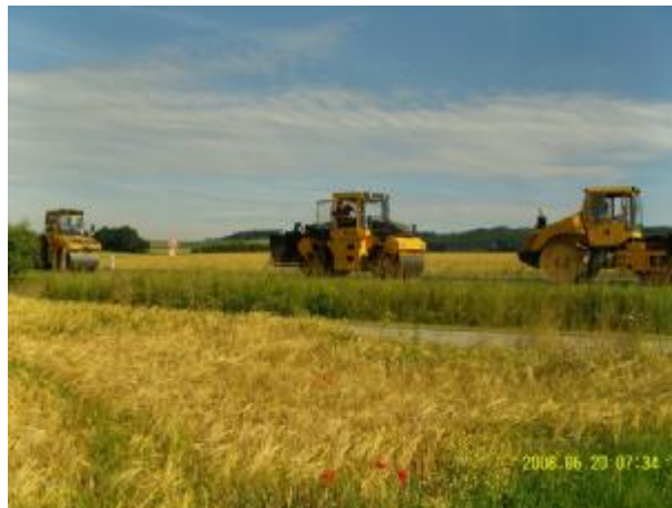
Bild 605: Bau-km 0+200 Walzenfolge bei halbseitigem Einbau
