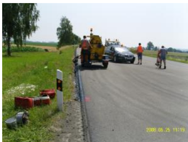
Bild 825: Bau-km 0+740 Abdichtung des höher liegenden Fahrbahnrandes
