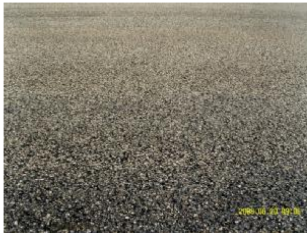
Bild 629: Bau-km 0+375 eingewalztes Abstumpfmaterial
