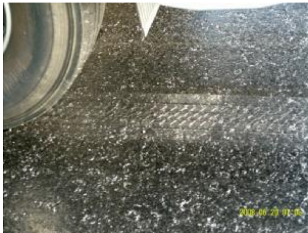
Bild 600: Bau-km 0+025 Reifenspuren in der abgetrockneten Bitumenemulsion
