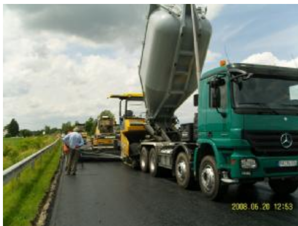
Bild 675: Bau-km 1+150 vollflächiger und gleichmäßiger Ansprühfilm in Bauphase 2
