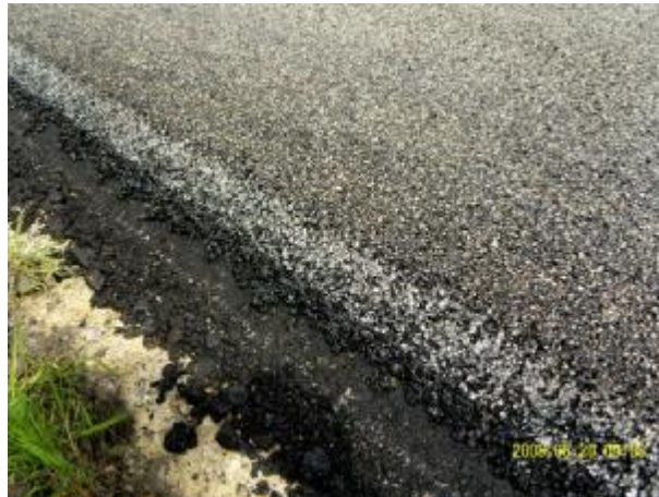
Bild 628: Bau-km 0+375 mit Kantenrolle angedrückte Außenflanke
