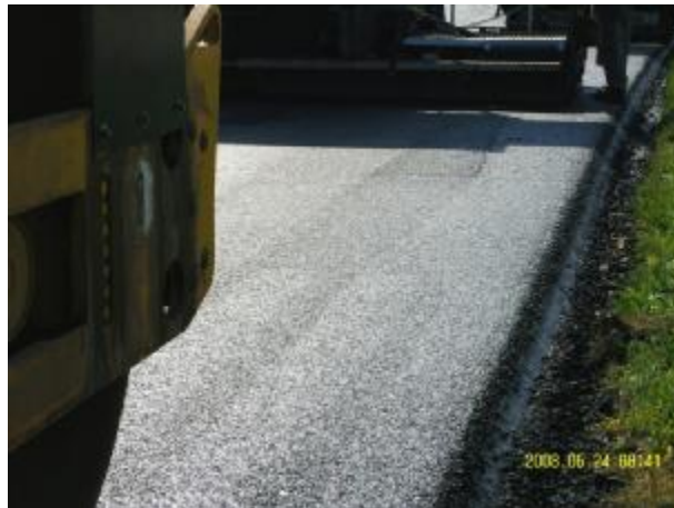
Bild 727: Bau-km 1+331 Bohle des Vögele-Fertigers überlappt mit Einbaustreifen des Demag-Fertigers
