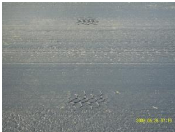
Bild 792: Bau-km 0+000 Profileindrücke in der Bitumenemulsion auf gefräster Unterlage
