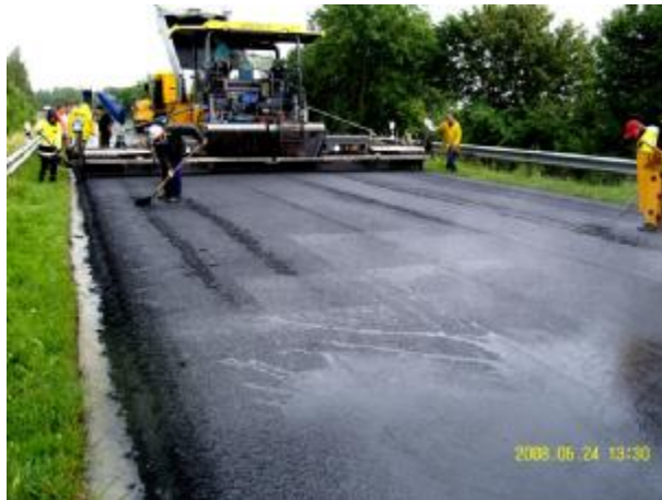
Bild 763: Bau-km 2+202 bei Regen erhebliche Unregelmäßigkeiten in der eingebauten Schicht
