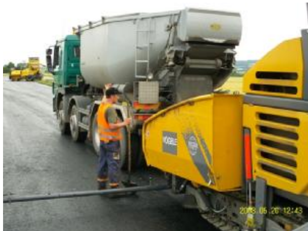
Bild 670: Bau-km 1+140 Vierachs-LKW mit Container-Aufbau
