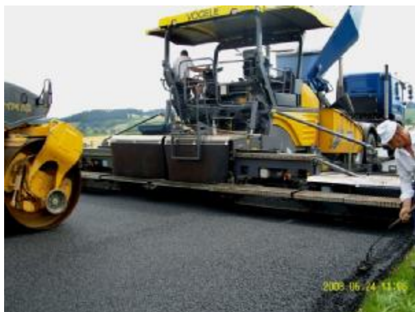
Bild 746: Bau-km 1+757 Fertiger Vögele Super 1900-2
