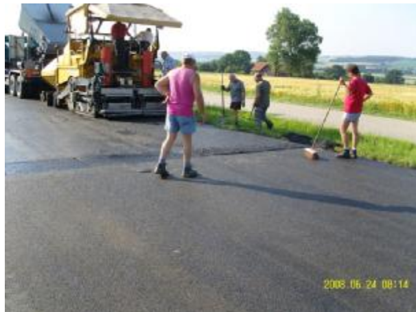
Bild 721: Bau-km 1+210 vorausfahrender Demag-Fertiger
