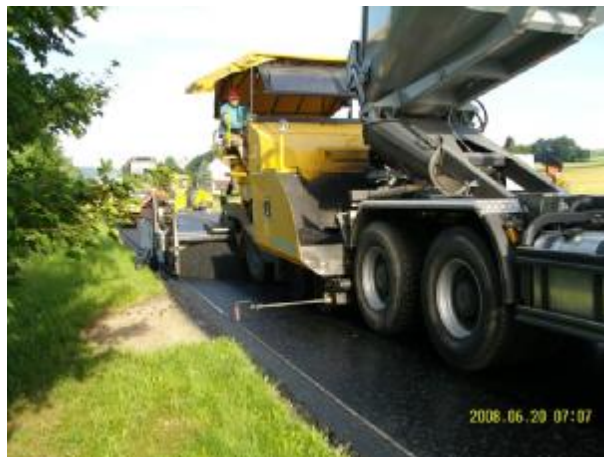
Bild 603: Bau-km 0+025 Beschickung des Demag-Fertigers
