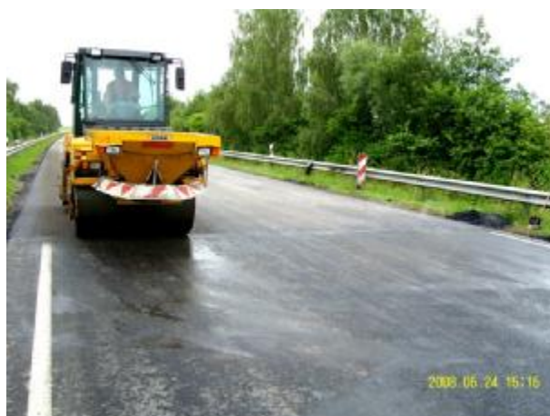
Bild 789: Bau-km 2+343 letzte Walzübergänge am Bauende
