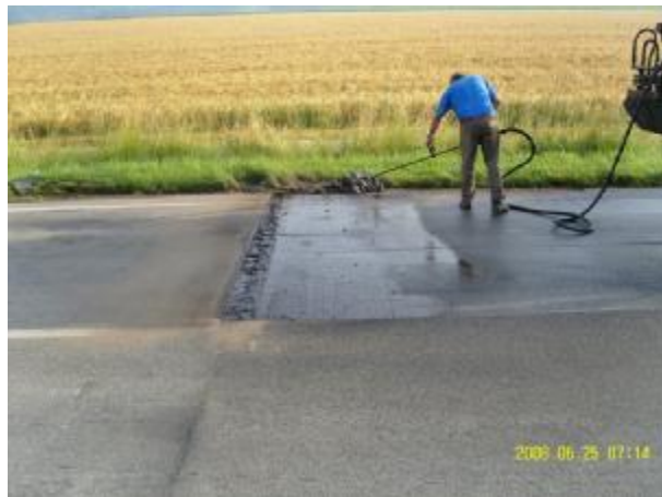
Bild 791: Bau-km 0+000 Ansatz für Bauphase 1a wird vorbereitet
