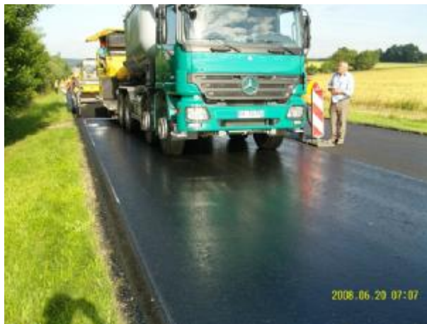
Bild 601: Bau-km 0+025 vollflächiger und gleichmäßiger Ansprühfilm
