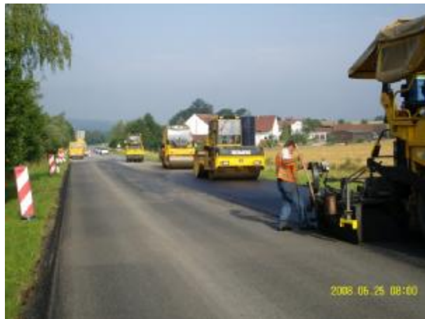
Bild 798: Bau-km 0+045 Walzenfolge bei halbseitigem Einbau in Bauphase 1a
