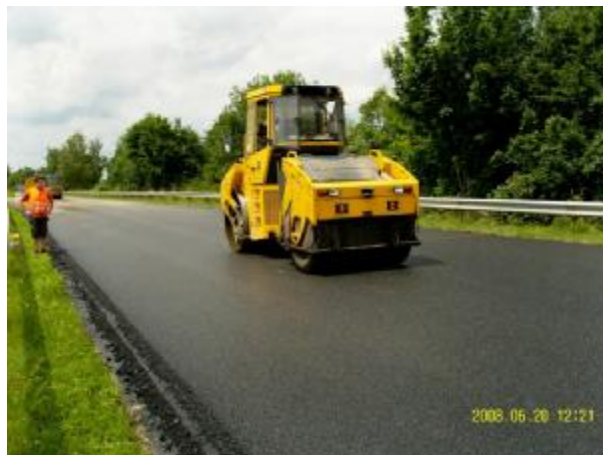
Bild 662: Bau-km 1+075 Kombiwalze Bomag BW 151 AC
