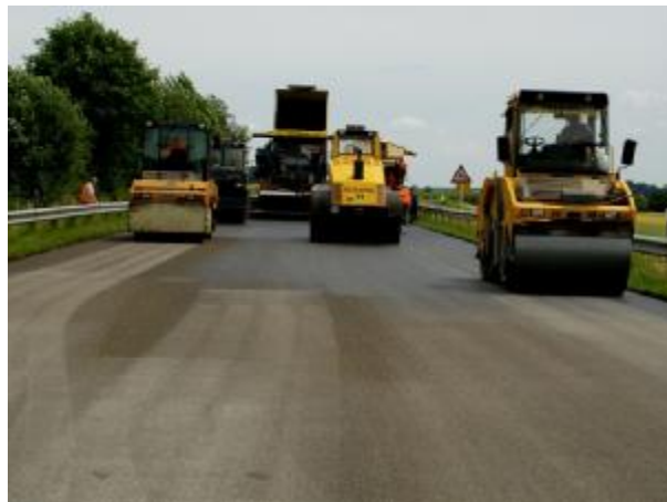
Bild 657a: Bau-km 1 +028 Abstumpfen nahe am Fertiger, Überlappungen erkennbar
