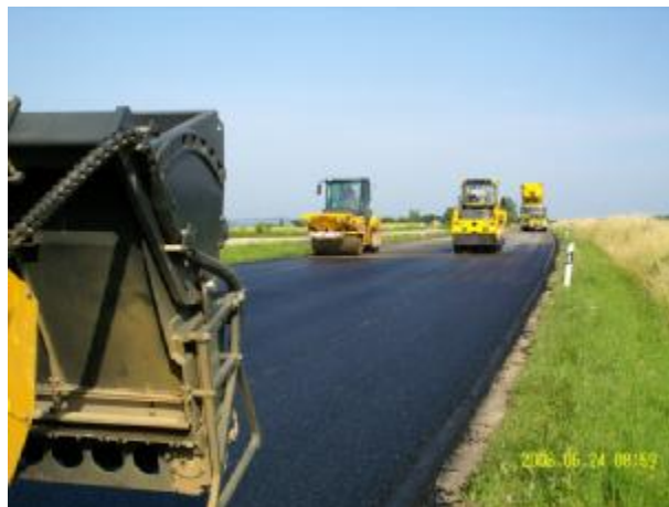
Bild 734: Bau-km 1+402 Walzenfolge bei voller Einbaubreite, Abstumpfen mit Streuteller
