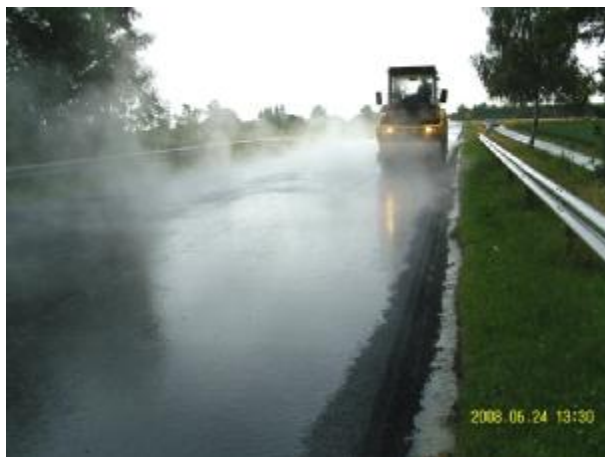
Bild 764: Bau-km 2+202 bei Regen geschlossener Wasserfilm auf eingebauter Schicht
