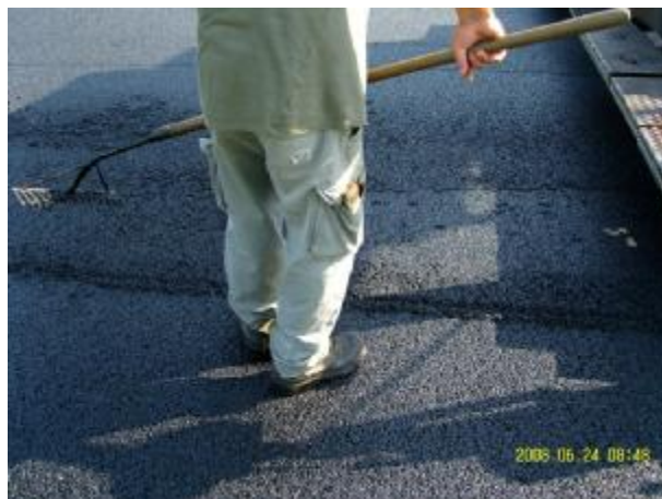
Bild 729: Bau-km 1+372 Nacharbeitung von Hand in der Überlappungszone
