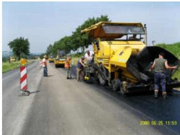
Bild 830: Bau-km 0+695 Fertiger Demag DF 115 P
