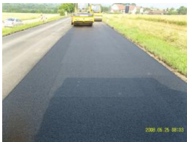
Bild 802: Bau-km 0+170 Verdichtungsfortschritt von Außen nach Innen
