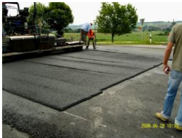
Bild 643: Bau-km 0+808 misslungene Schicht am Ansatz der Bauphase 2
