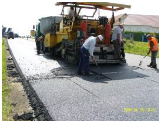
Bild 816: Bau-km 0+645 Ansatz für Einbau in zwei Streifen in Aufweitungszone
