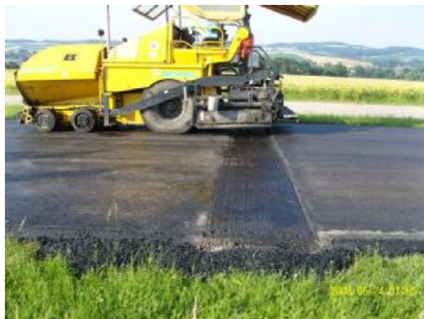
Bild 719: Bau-km 1+310 zurückgeschnittener Tagesansatz
