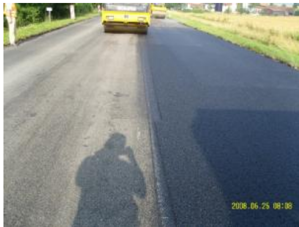
Bild 800: Bau-km 0+085 Verdichten der Nahtzone von der kalten Seite
