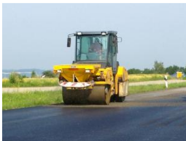
Bild 734a: Bau-km 1+402 Kombiwalze Hamm HD 75 mit Streuteller
