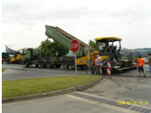
Bild 642: Bau-km 0+808 Sattelzug vor Vögele-Fertiger, davor versetzt der Demag-Fertiger
