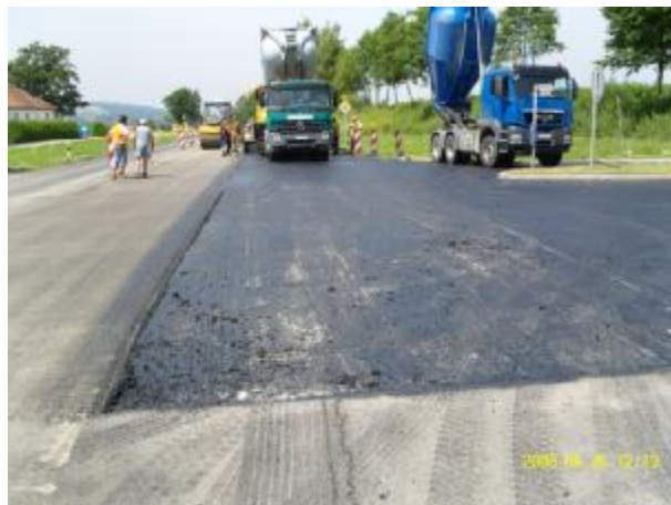
Bild 832: Bau-km 0+808 Erreichen des Bauendes der Bauphase 1a im Vordergrund gefräste Fläche (vgl. 643)
