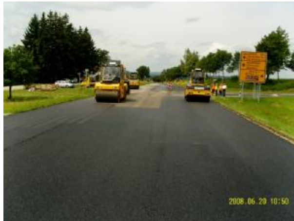
Bild 651: Bau-km 0+850 Vergleichmäßigung der Oberfläche ca. 30 m hinter dem Ansatz der Bauphase 2
