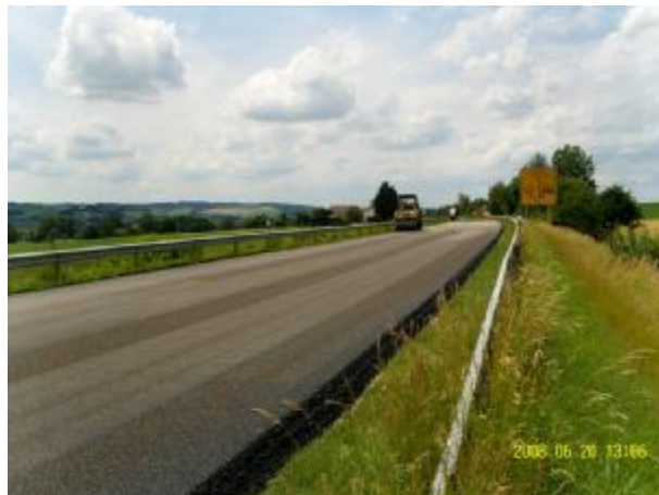
Bild 678: Bau-km 1+185 Abstreubild mit Tellerstreuer und geringerer Gleichmäßigkeit wie mit Abstreubalken
