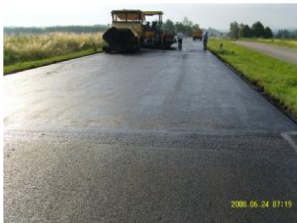
Bild 718: Bau-km 1+310 morgendliche Feuchtigkeit auf der Unterlage
