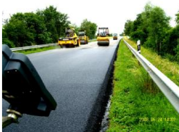
Bild 769: Bau-km 2+252 bei Ausklingen des Regens wieder gleichmäßige Schicht
