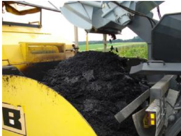
Bild 2268: Bau-km 0+700 kalte Mischgutbrocken selbst bei geschlossenem Container-Aufbau
