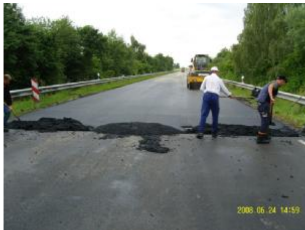
Bild 786: Bau-km 2+243 Verteilen des Asphaltmischgutes von Hand am Bauende
