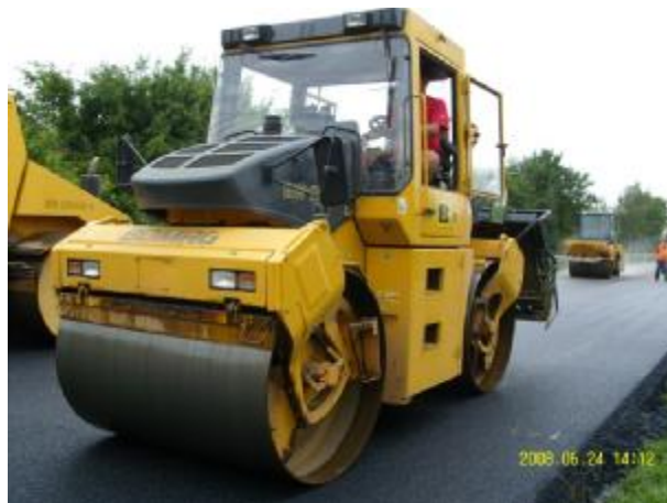
Bild 776: Bau-km 2+282 Tandemwalze Bomag BW 174 AD mit Streubalken
