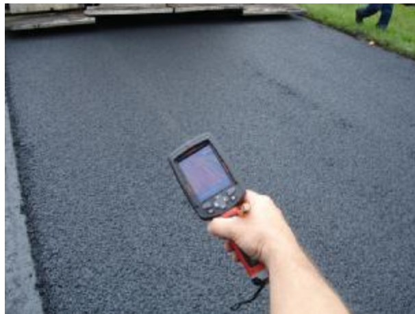
Bild 2273: Bau-km 0+700 erkennbar beginnende Unregelmäßigkeiten in der eingebauten Schicht
