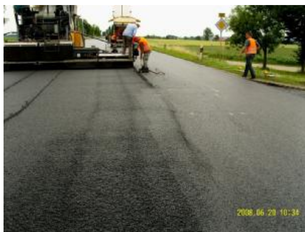
Bild 645: Bau-km 0+808 wie 643, erhebliche Unregelmäßigkeiten der eingebauten Schicht
