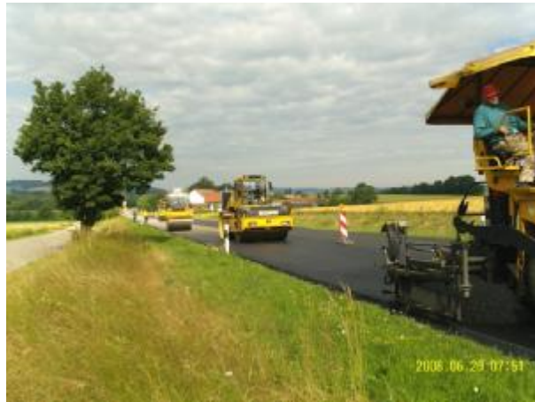
Bild 618: Bau-km 0+195 Abstumpfen durch zweite Walze
